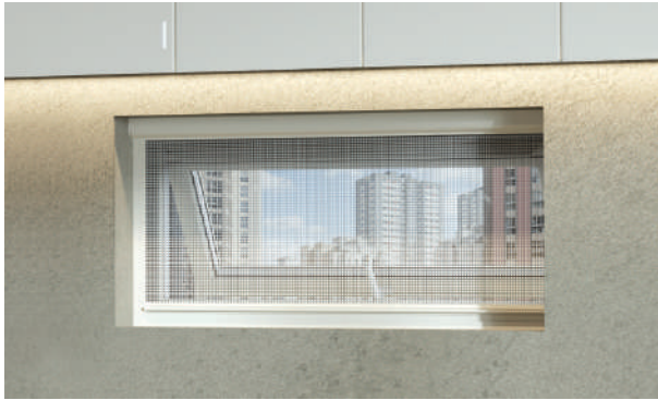
물 방충망 적용으로 좁은 공간의 조망권을 높인 프로젝트창 환기 시에만 물 방충망을 내려 환기를 하지 않을 때에는 깔끔한 뷰를 제공합니다.
